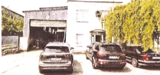
Виробничий цех та адміністративна будівля — вхід
