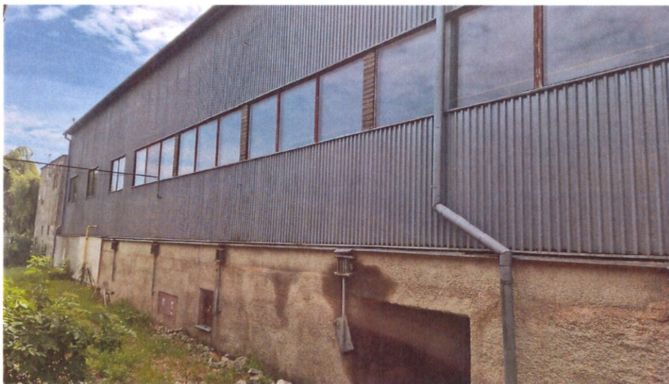
Виробничий цех — актуальний вигляд збоку. Джерепо: актуальна фотодокументація TS Steel s.r.o.
