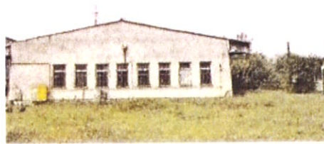
Будівля майстерні — вигляд збоку
